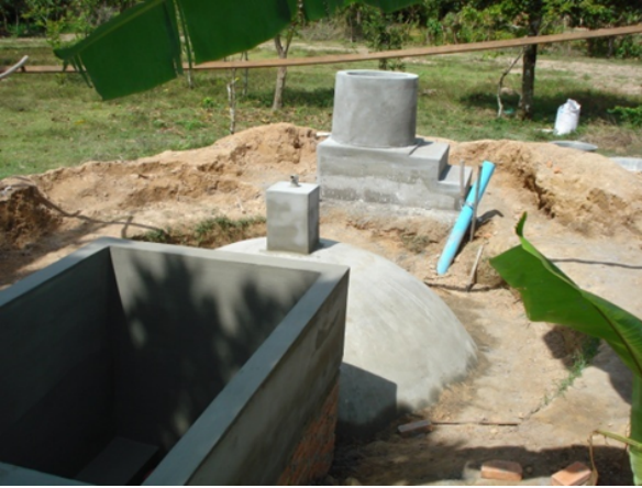
រូបភាពទី៥៖ ការសាងសង់ឡដីដុះឧស្ម័នដើម្បីផលិតហ្គាសសម្រាប់ចម្អិនអាហារ និងភ្លើងបំភ្លឺ ចំណែកឯកាកសំណល់ប្រើប្រាស់ជាដីសម្រាប់ការធ្វើកសិកម្ម
